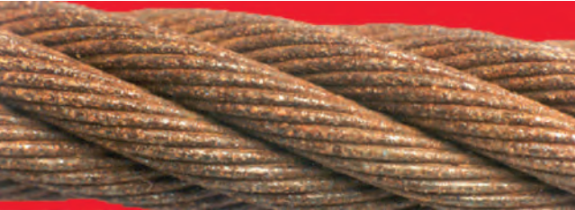
i. Dış korozyonun yakınlaştırılmış şekli
